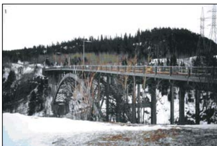
Fig. 12: Arvida bridge (Quebec, Canada)
