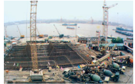
Fig. 19. Foundations for Yang Pu Bridge
