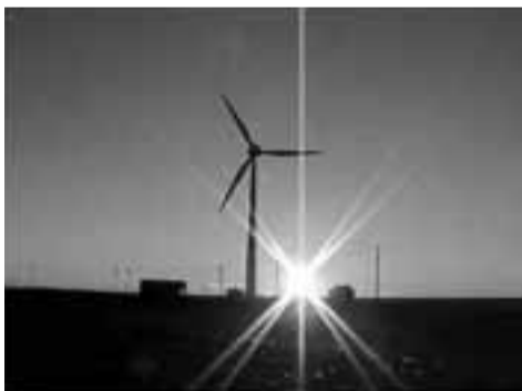
Aerogenerador. Parque eólico «Jorge Romanutti» de Pico Truncado
