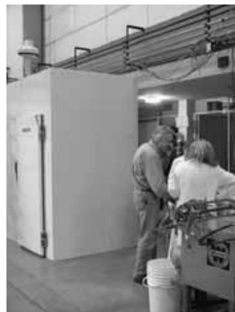
Cámara de secado
