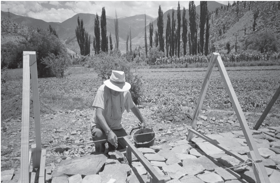
Tilcara, construcción del deshidratador solar
