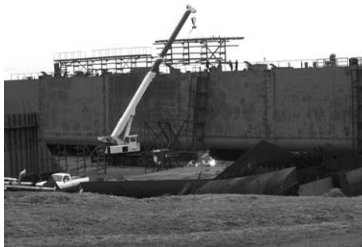
El astillero en plena producción de un buque tanque petrolero
