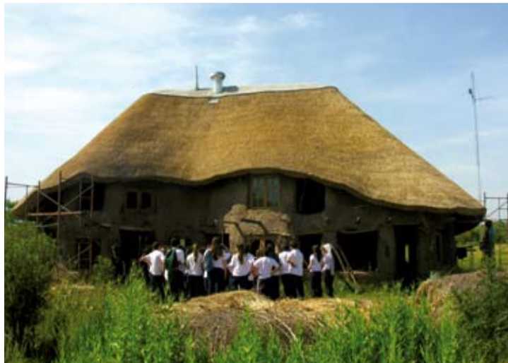
Construcción realizada en Modelado Directo en la Ecovilla Gaia.
